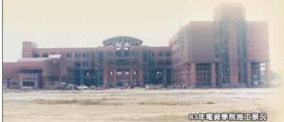
83年電資學院施工景況
