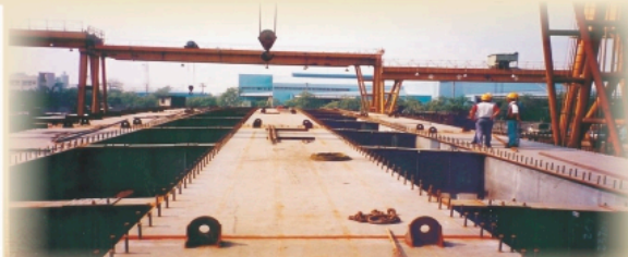
88年大學橋施工景況
